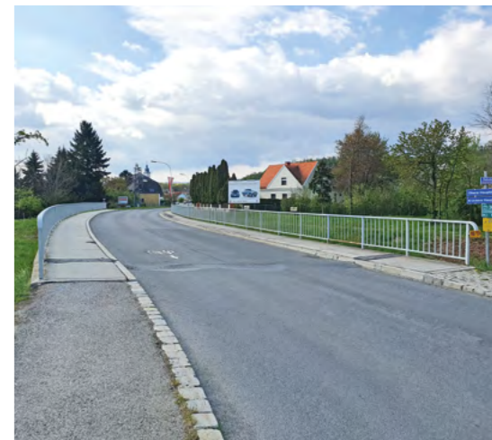
Die Brücke bei der Ortseinfahrt Steinberg wird abgerissen und komplett neugebaut
