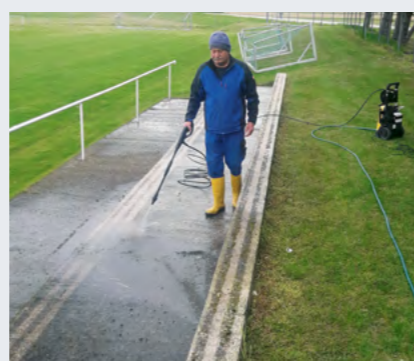
Jonny Seifner bei der Arbeit an der Tribüne. In den kommenden Wochen werden neue Sitzbänke beim SV Steinberg montiert
