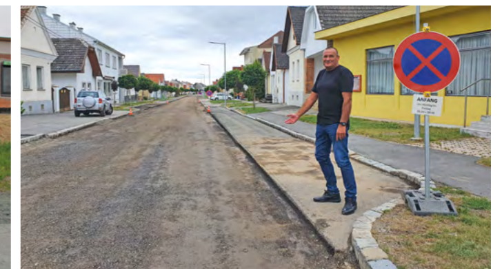
Die Asphaltierungsarbeiten in der Unteren Hauptstraße sind bereits abgeschlossen
