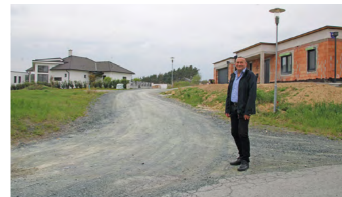
Bürgermeister Manfred Schmidt bei der Besichtigung der Baustelle am Kirchberg
